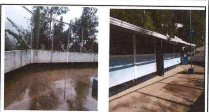
Foto 4: Pintura de muros interiores y exteriores por deterioro
